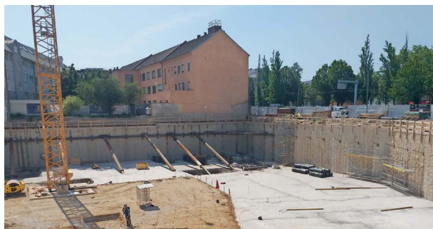
Freigelegte MIP-Verbauwand
