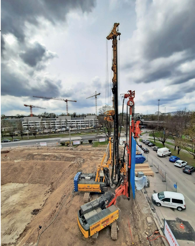
Eine Bauer RG27 bei der Herstellung der MIP-Verbauwand
