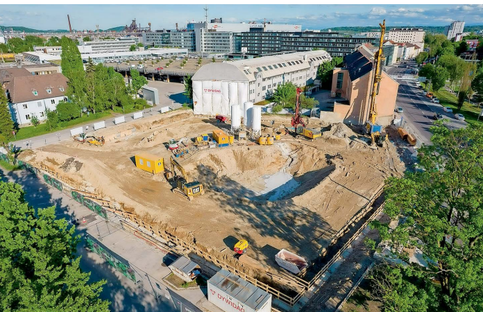
Überblick über das Baufeld
