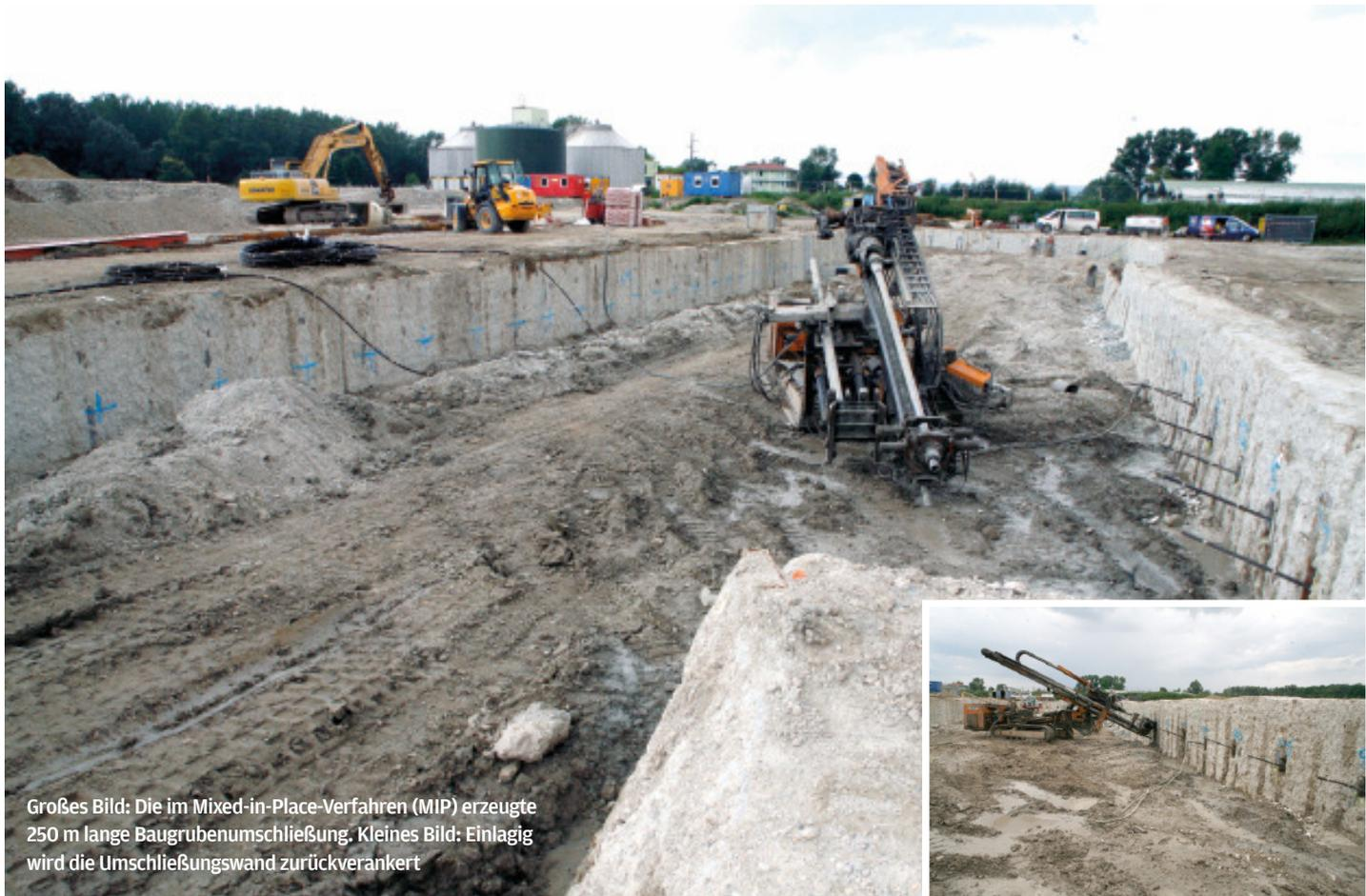
Großes Bild: Die im Mixed-in-Place-Verfahren (MIP) erzeugte 250 m lange Baugrubenumschließung. Kleines Bild: Einlagig wird die Umschließungswand zurückverankert
