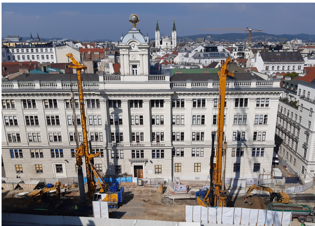
Abbildung 1: Baulos U2/22 Schacht „Landesgerichtstraße“ (2x BAUER BG45)
