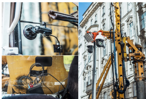
Abbildung 4: Baulos U5/22 Schacht „Schwarzspaniergasse“, Intelligente Kameras b.navigate (BAUER BG 40)
