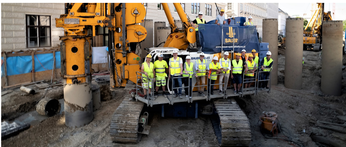
Abbildung 5: #bauerpower am Baulos U2/22 Schacht „Landesgerichtsstraße“
