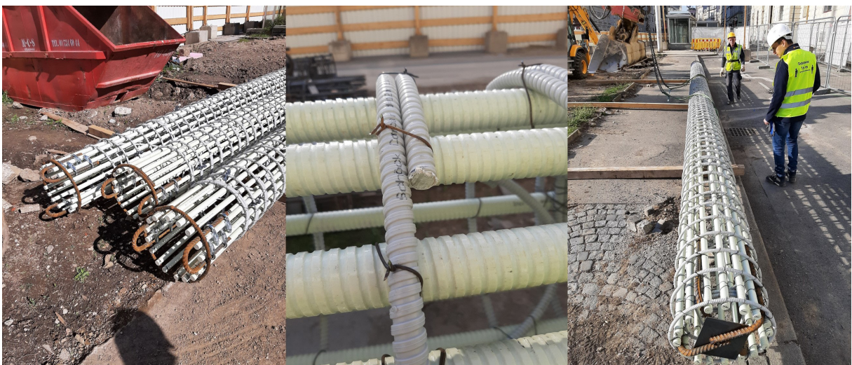
Abbildung 2: Herstellung und Abnahme der GFK-Bewehrung am Baulos U2/22 Schacht „Tulpengasse“
