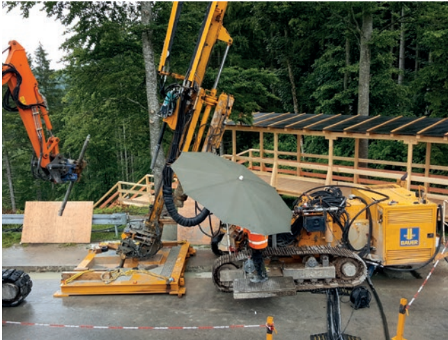
Staudamm, Roßhaupten, Deutschland Erstellung eines Felsinjektionsschleiers bis in eine Tiefe von maximal 91 m.
