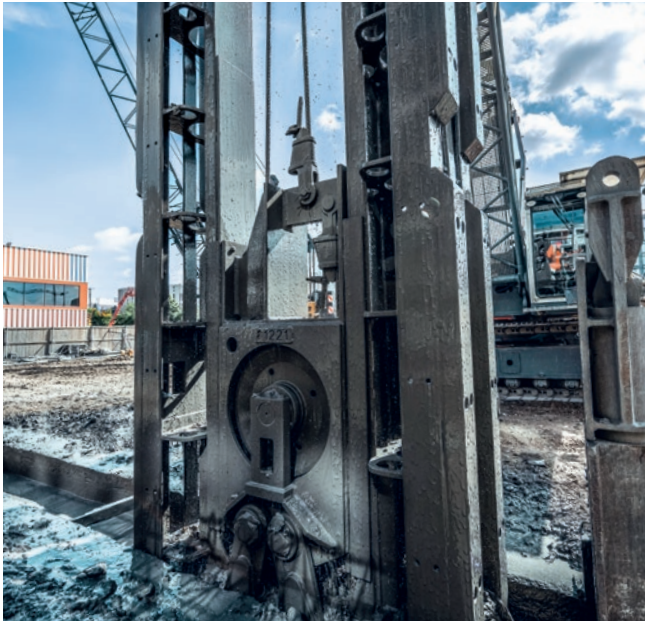
Messeingang Süd, Frankfurt am Main, Deutschland Ausführung einer 2-Phasen-Schlitzwand unter Einsatz eines MC 64 Seilbaggers mit Greifer.
