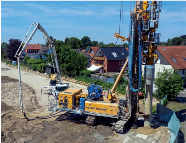
Businesspark, Hannover, Deutschland Herstellung einer überschnittenen Bohrpfahlwand mit einem Durchmesser von 880 mm und 16 m Tiefe mittels DKS-Verfahren.
