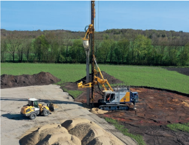
Windpark, Silberstedt, Deutschland Zur Gründung mehrerer Windenergieanlagen wurden insgesamt 3.200 m Rüttelstopfverdichtung durchgeführt.
