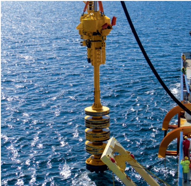
Beatrice Offshore Windpark, Orkney, Schottland Gründung einer Gezeitenturbine mithilfe des Unterwasserbohrgeräts BSD 3000.
