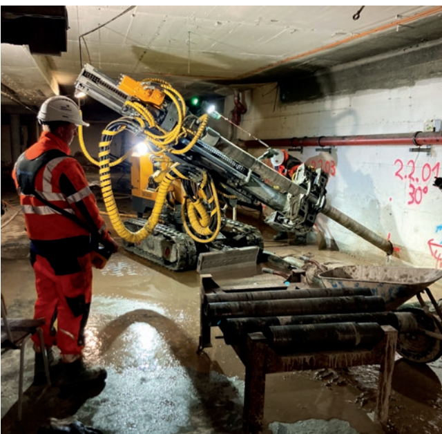
LVR-Haus, Köln, Deutschland Einbau von 80 Verpressankern als Litzendauerankern zur Rückverankerung einer Tiefgaragenwand.
