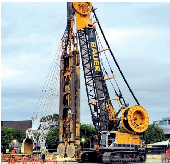
Hobson Bay, Melbourne, Australien Herstellung von zwei Schächten unter Einsatz eines MC 96 Seilbaggers mit einer BC 48 Schlitzwandfräse.
