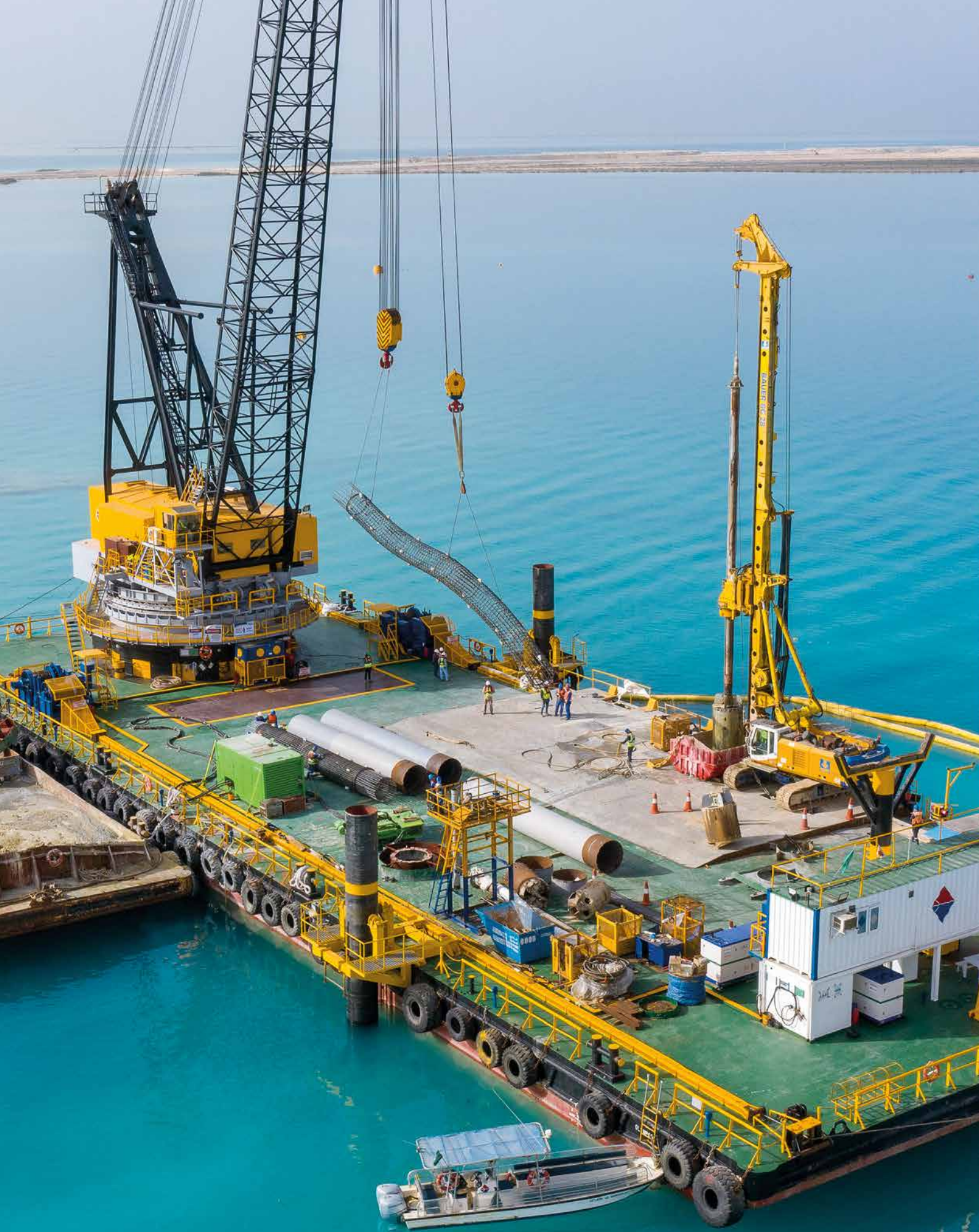
Saudi-Arabien Am roten Meer entsteht ein neues nachhaltiges Erholungsgebiet. Dafür werden auch mehrere Brücken gebaut. Bauer stellte hierfür neben drei Testpfählen insgesamt 124 Pfähle her.
