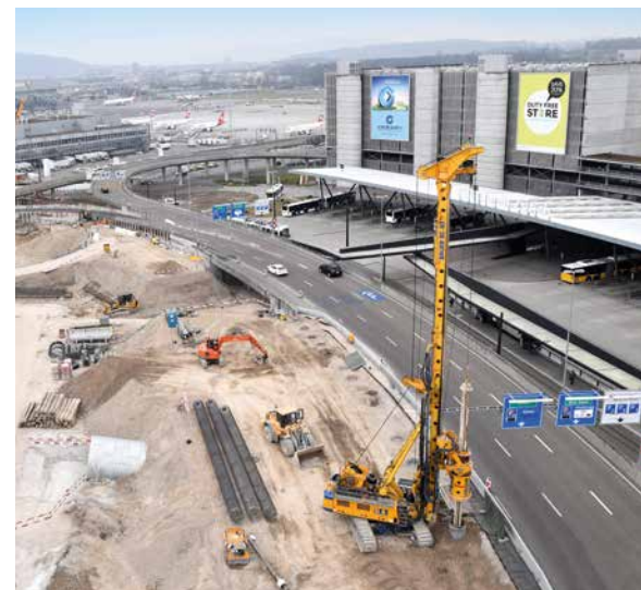
Für die Wärme- und Kälteversorgung des Quartiers „The Circle“ wurde eine Energiepfahlanlage mit einer Gesamtleistung von rund 1,8 MW am Züricher Flughafen gebaut.
