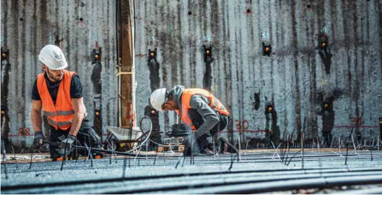
Etwa 10 km Rohrleitungen wurden für die geothermische Aktivierung einer Energiewand verlegt.
